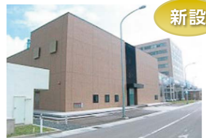
既存の緊急時対策所
